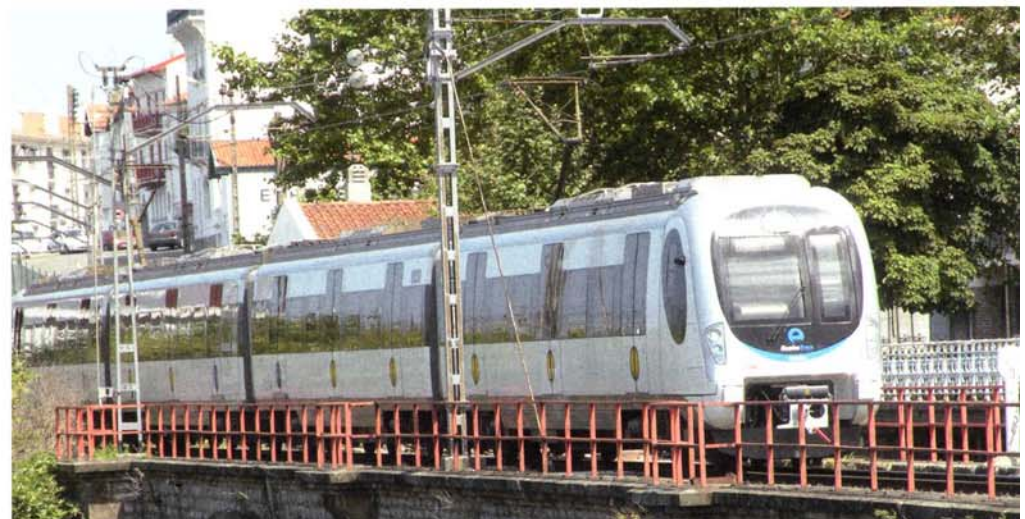
Topo 902 recorriendo el Puente del Bidasoa. 28-7-11. Foto Koldo.
